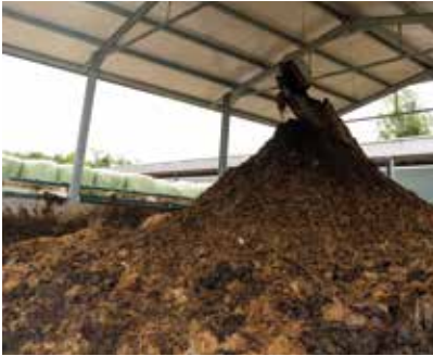
Copertura area stoccaggio reflui zootecnici.
